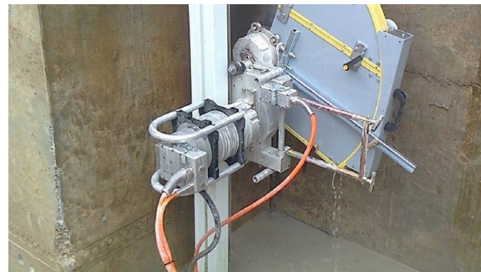
Betonsägemaschine / Concrete saw
